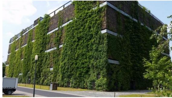
Figuur 31. Parkeergarage High Tech Campus (Eindhoven)
