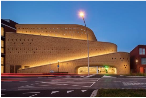
Figuur 30. Parkeergarage Katwolderplein (Zwolle)
